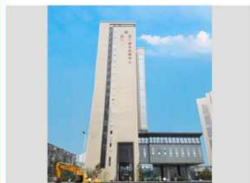
投入使用的四川省治未病中心大楼
